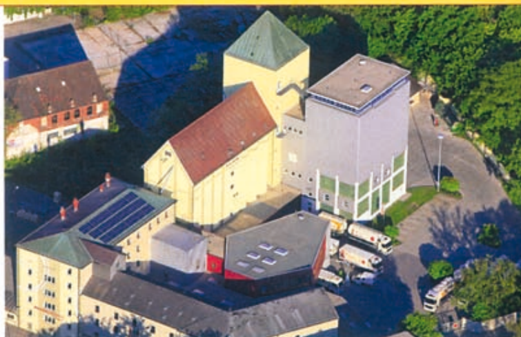
Die Meyermühle (unser Foto zeigt eine Luftaufnahme) ist der größte Verarbeiter von Ökomehl-Erzeugnissen in Europa. Fotos (2): Meyermühle
